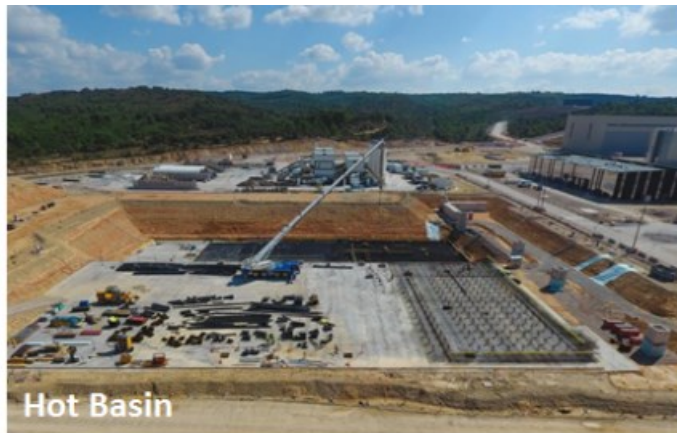
Закончено сооружение бассейна охлаждения (объемом 27 000м 3 )
