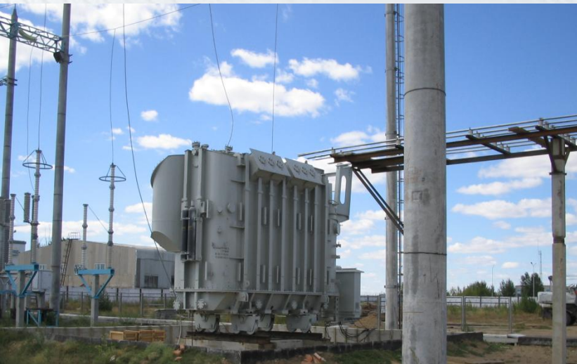
Главный силовой трансформатор
