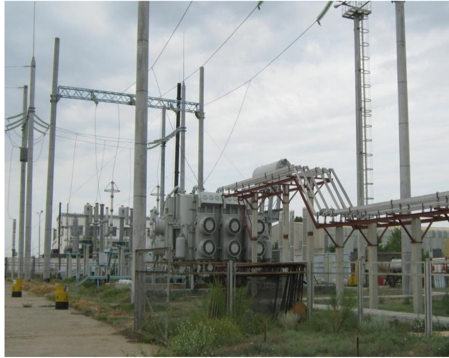
Главной трансформатор подстанции
