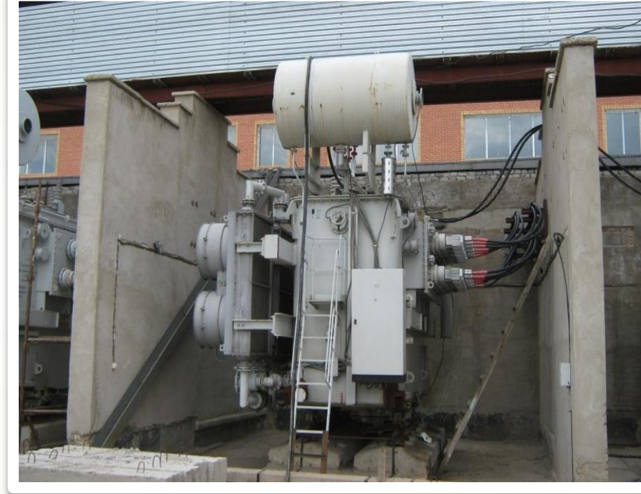
Трансформаторы системы электроснабжения электромагнитных обмоток
