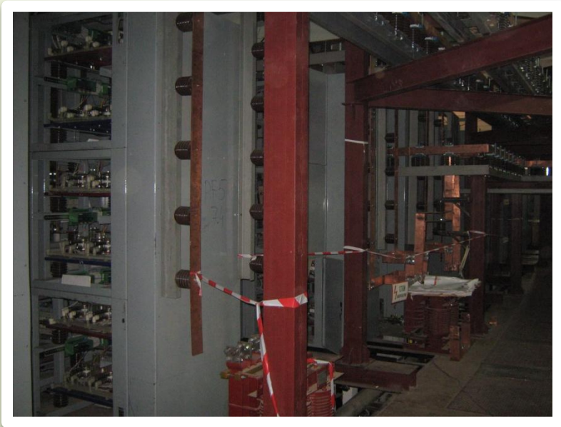
Шкафы тиристорных преобразователей системы электроснабжения электромагнитных обмоток
