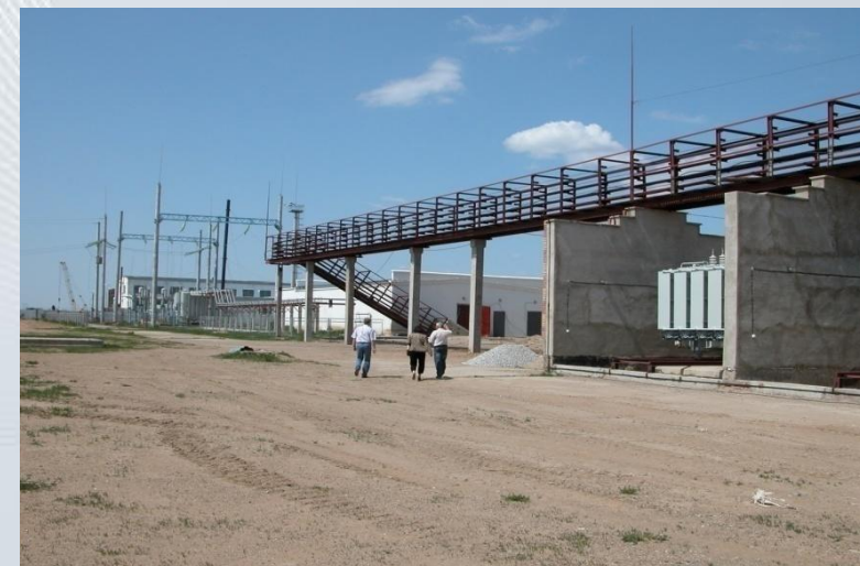
Силовые кабельные линии
