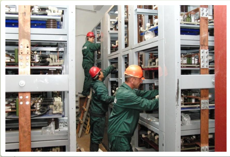
Шкафы тиристорных преобразователей системы электроснабжения электромагнитных обмоток
