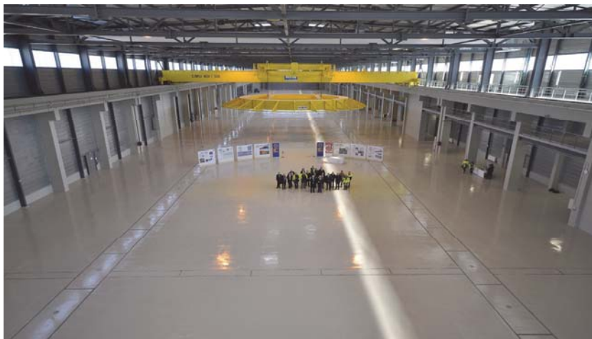
Рис. 25.6. Здание для намотки полоидальных катушек (длина – 257 м, ширина – 45 м, высота – 18 м)
