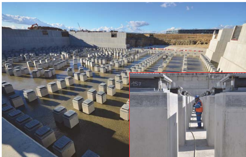
Рис. 25.20. Сейсмостойкий фундамент ИТЭРа
