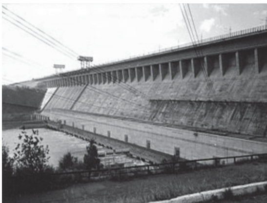
Рис. 2.2. Плотина Братской ГЭС
